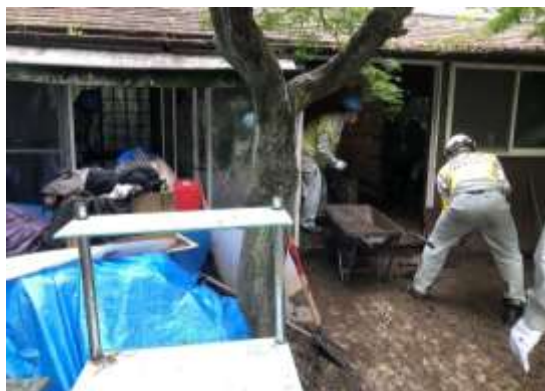
室内の泥を庭先に運搬
