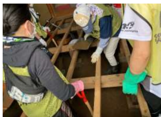
床下の泥だし
