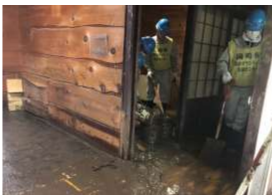
室内に溜まった泥の掻き出し
